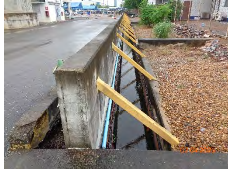
ภาพที่ 2-34 รางระบายน้ำฝน แยกออกจากระบบบำบัดน้ำเสีย
