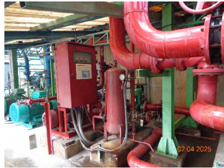
ภาพที่ 2-55 Fire Water Pump ชนิดขับเคลื่อนด้วยไฟฟ้า
