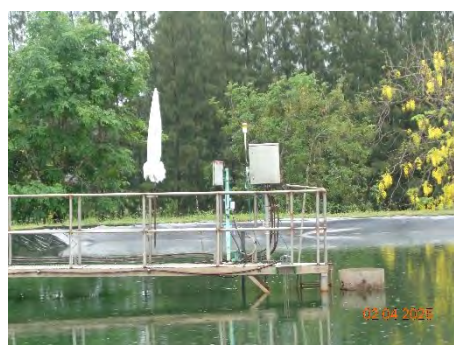
ภาพที่ 2-32 ระบบ COD Monitoring Online บริเวณบ่อพักน้ำทิ้ง (Final Pond)
