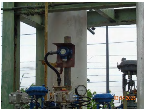
ภาพที่ 2-70 เครื่องตรวจจับก๊าซไฮโดรเจน (Flammable Gas Detector)
